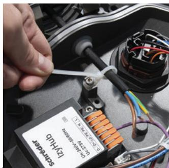
Una fascetta plastica o di metallo assicura la posizione del cavo di alimentazione all'interno dell'apparecchio.
