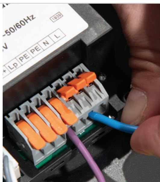
Con le leve sollevate, i cavi sono facili da inserire nella posizione corretta indicata. Quindi è possibile spingere in basso le leve per fissare la connessione elettrica.
